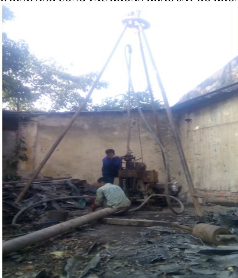
HÌNH 2. HÌNH ẢNH CÔNG TÁC KHOAN KHẢO SÁT HỒ KHOAN HK3
